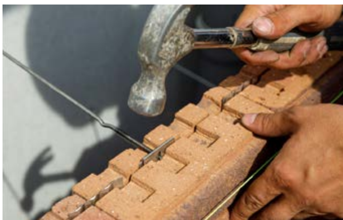
Foto: circulair droogstapelsysteem.
