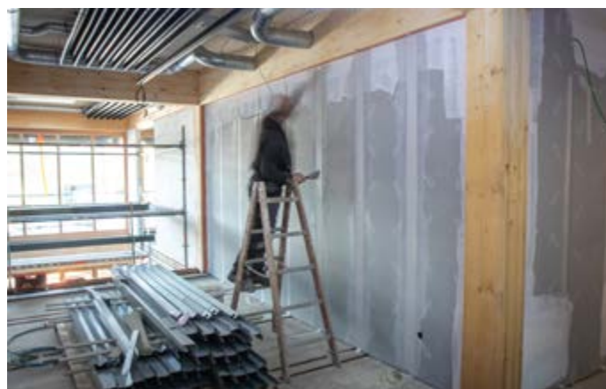
Photo : cloisons de plâtre démontables et réutilisables.
